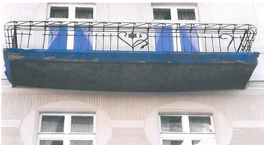
Fot. nr 3. Balkon II kondygnacji.
