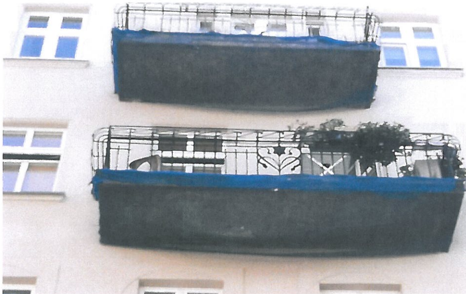
Fot. nr 4. Balkon III i IV kondygnacji.
