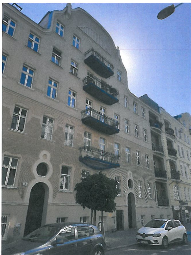
Fot. nr 5. Widok ściany frontowe z balkonami. Widoczny fragment chodnika na którym stanie podnośnik teleskopowy. wraz z piłą ścienną.
